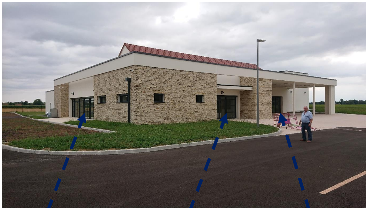
Baies salle secondaire
